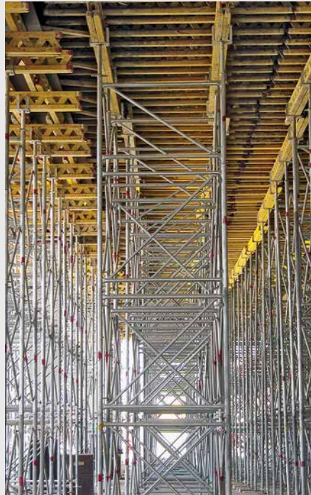
2 x GT 24 ana taşıyıcı ve GT 24 çapraz taşıyıcı ile PD 8 masa kalıp iskelesi.
