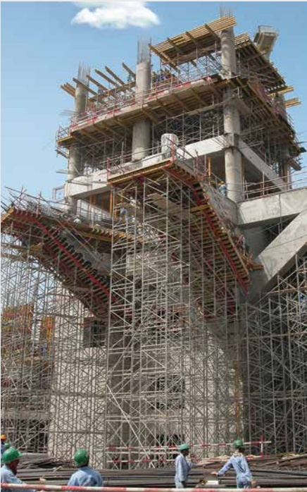
Alışveriş merkezi inşaatı için eğimli beton yüzeyleri ile PD 8 kalıp iskelesi.
