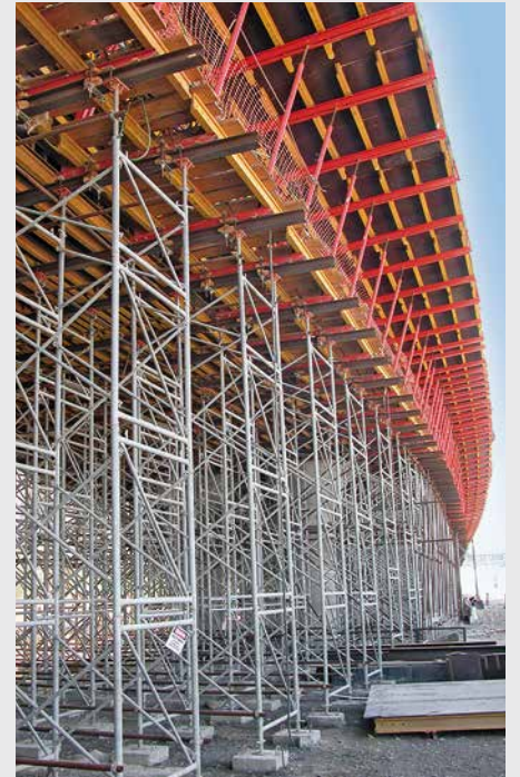
GT 24 ızgaralar ve 2 x GT 24 mahya ile PD 8 döşeme masa iskeleleri.
