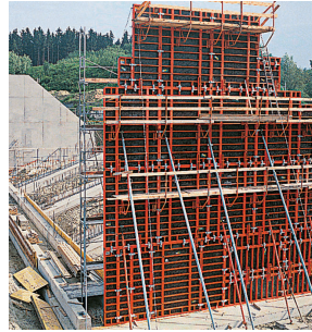
3,30 m'ye kadar panel yükseklikleri, 2,40 m'ye kadar panel genişlikleri (standart sistem).
