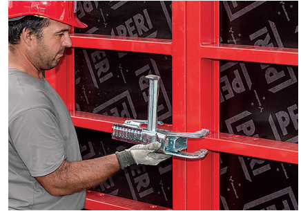
BFD kilit ile sağlam bağlantı noktalarının oluşturulması.
