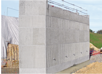
TRIO Structure modeli ile özel beton yüzeyleri için kalıp kontraplağının isteğe göre seçildiği ön montajlı paneller.
