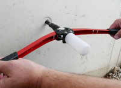
Tıkaçı el perçinleyicisi ile yerleştirin.
